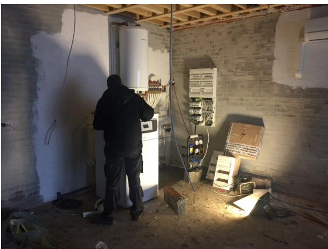
I værkstedet er varmepumper og elektrisk installation ved at blive sat op.
